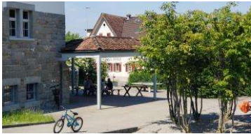
Blick auf das Vordach, vom Osten her. Das Schrägdach ist dem Schulhaus Oberwil angepasst und stellt keinen Fremdkörper dar
