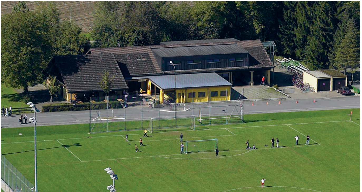
Clubhaus und Garderobengebäude des FC Baar (Quelle: Flying Camera 2007)
